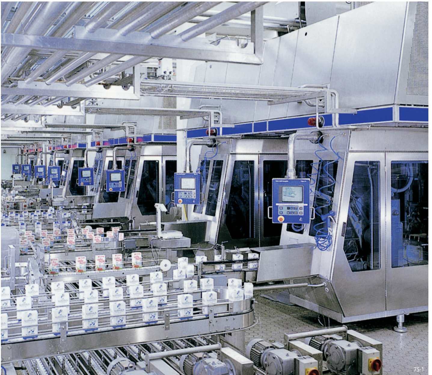
Limiteur de force PAG RINGSPANN comme limiteur de surcharge dans une usine de remplissage.
